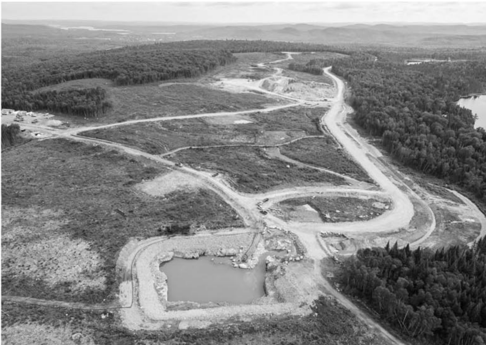
Vue aérienne du chantier à la fin août
